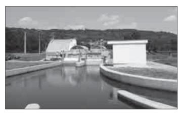
Elektrárna Ivančice, dvě soustrojí přímoproudých turbín, výkon 160 kW, celkem 320 kW, přivaděč i turbíny navrhlo VUT v Brně.
