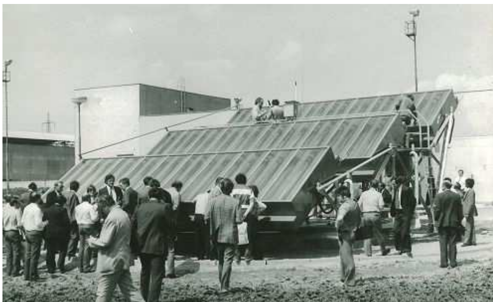
Obr. 2.4b : Jeden z prvních československých koncentračních kolektorů v chropýňském závodě Státního statku Kroměříž v den exkurze, realizace před rokem 1984. Ohříval 2500 l TUV denně, návratnost investice spočítána na 8 let
