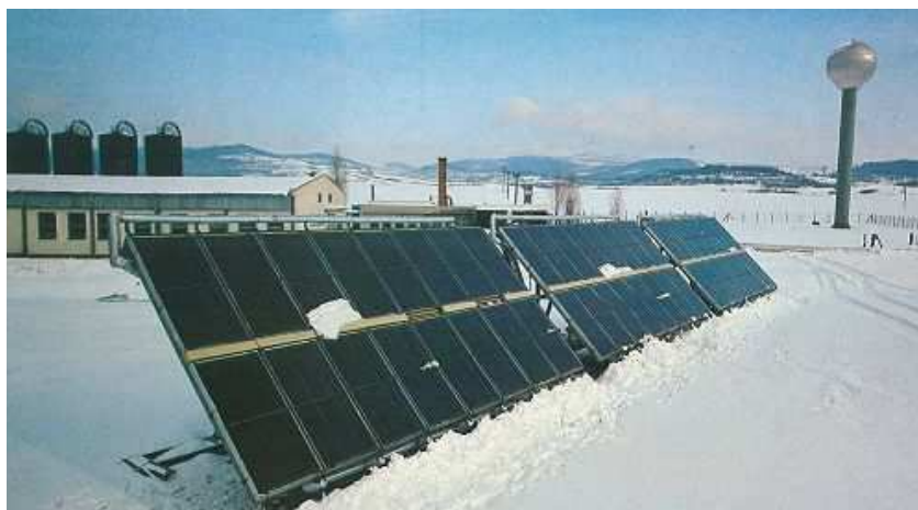
Obr. 2.4c : První velká československá solární soustava z celohliníkových kolektorů SALK 200 z roku 1984
