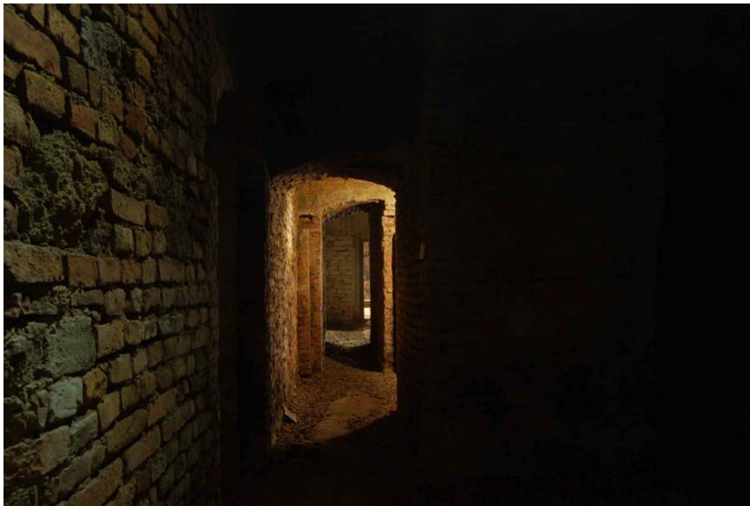
Prostor před instalací – pohled 1
