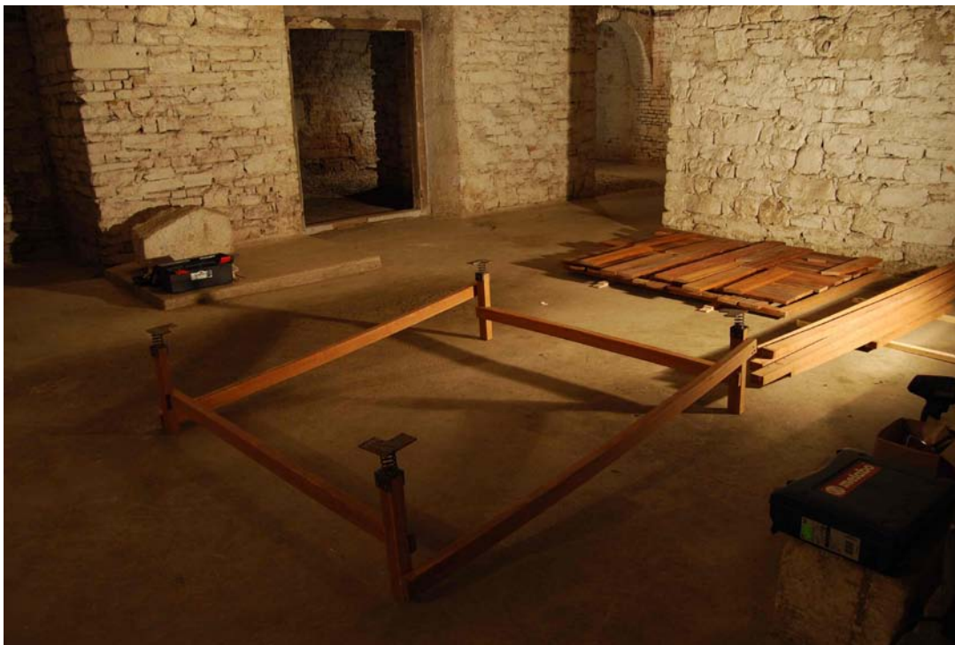
Dokumentace v průběhu práce – konstrukce
