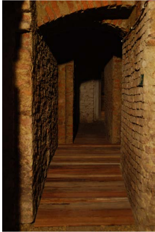
Instalace - nasvícení pro dokumentaci
