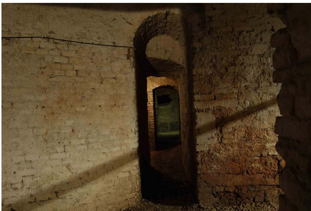
Prostor před instalací - pohled 2
