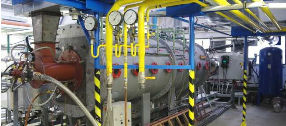
Obr. 11 Zkušebna UPEI Brno [30].
