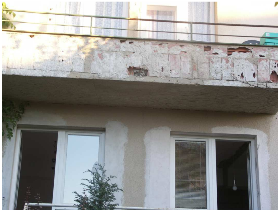
Detail posuzovaného překladu v prvním patře
