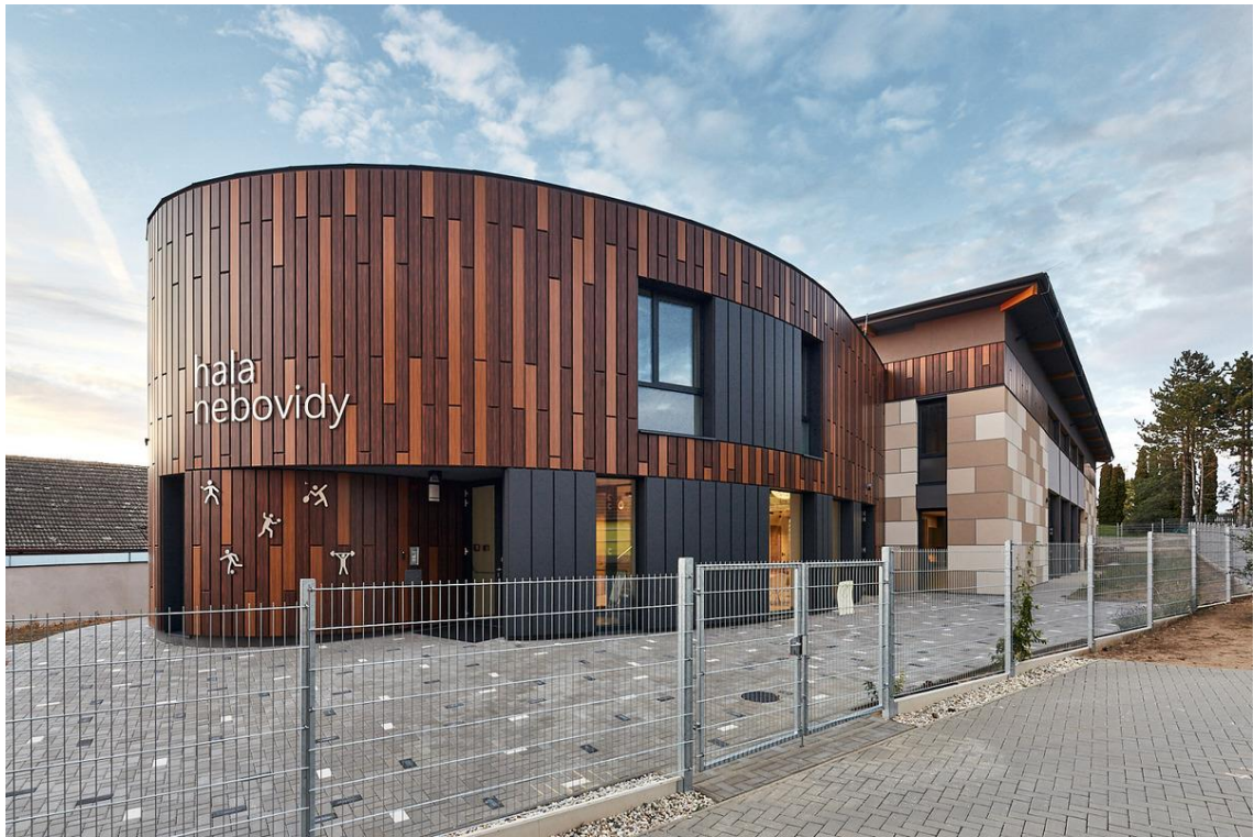
Obrázek 1: Hala – severozápadní pohled [19]
