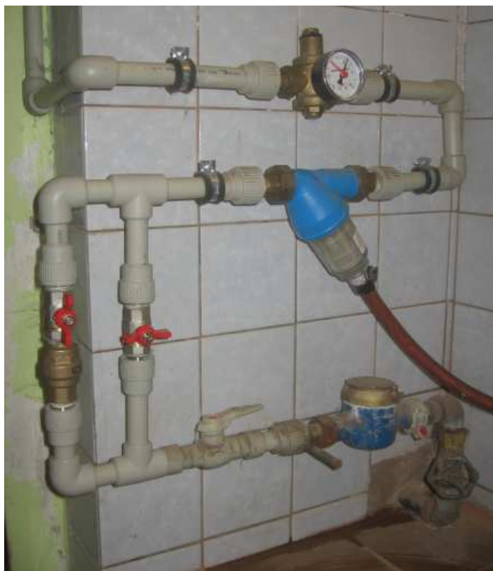
Obr. 4.2: Vodovodní přípojka s UFR [17]
