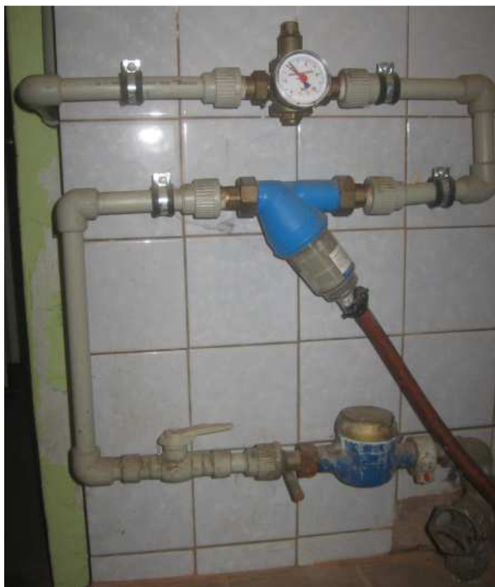
Obr. 4.1: Vodovodní přípojka bez UFR [17]
