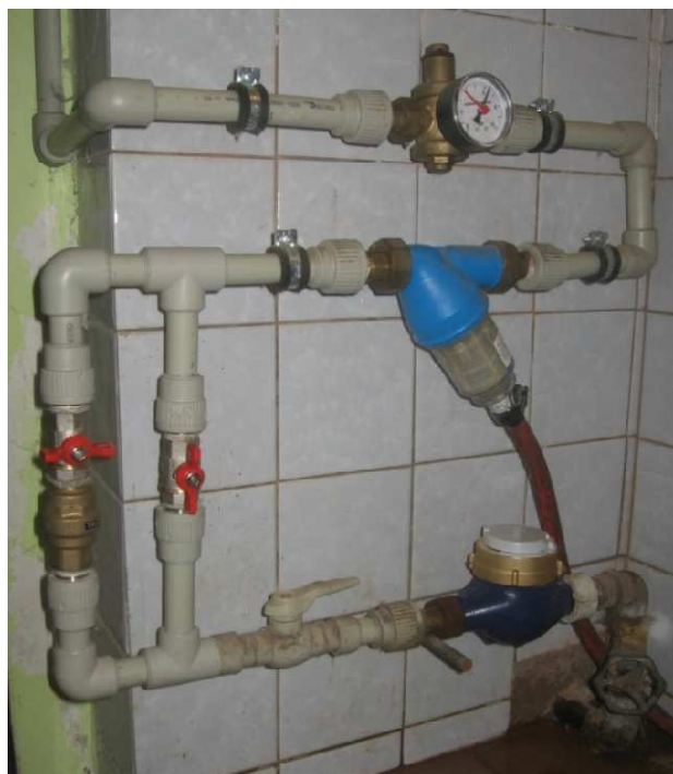
Obr. 4.10: Zapojení nového vodoměru [17]
