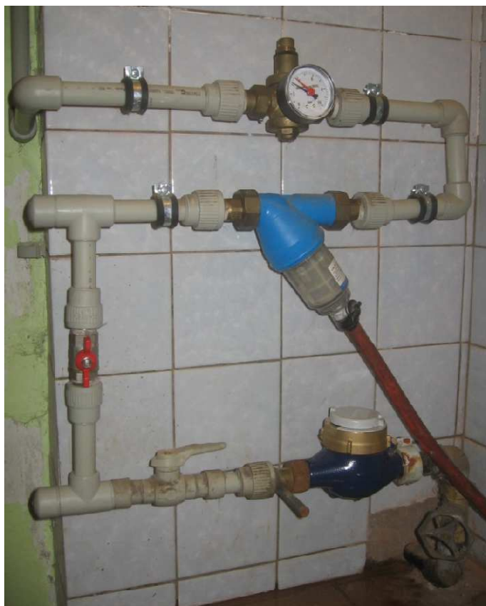
Obr. 4.14: Vodovodní přípojka po dokončení měření [17]
