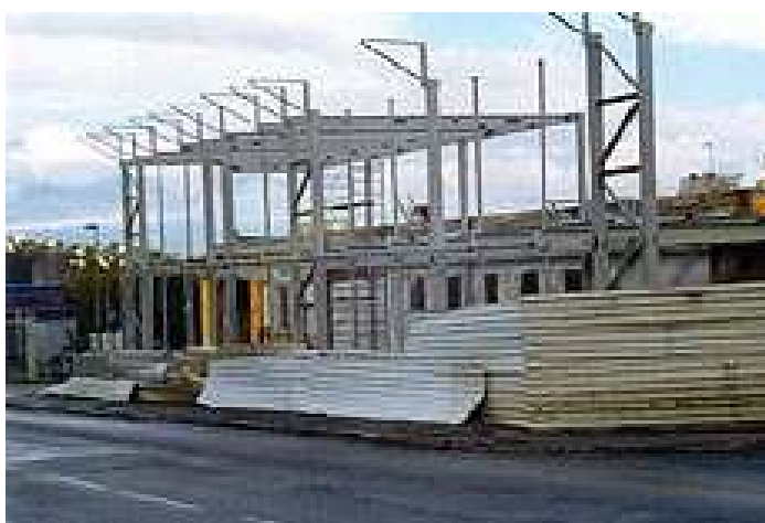
Obr.1.2 Ukázka stavby ocelových konstrukcí (5)
