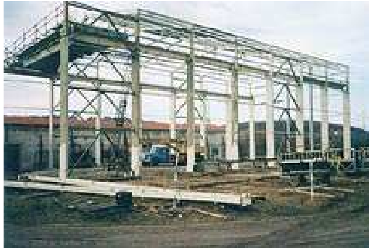
Obr.1.3 Ukázka stavby ocelových konstrukcí (5)
