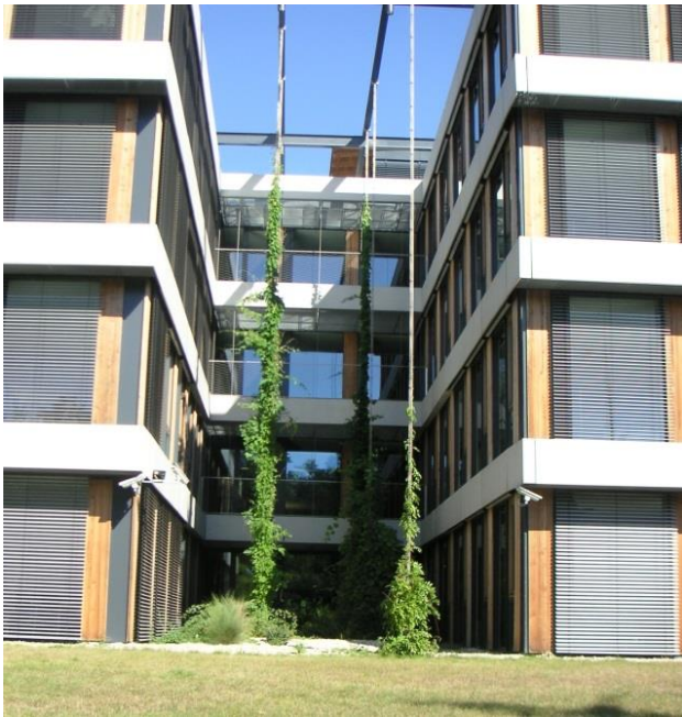
Obr. 8: Na zastíněných oknech jsou žaluzie svinuty
