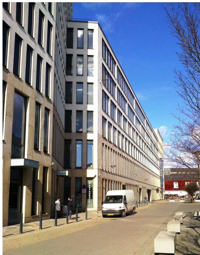
Obr. 6: Budova s dvojitým pláštěm
