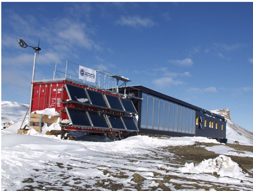
Hlavní provozní a ubytovací objekt s teplovzdušnými solárními kolektory, červený kontejner obsahuje technologii na ohřev TUV a spalování pevných odpadů
