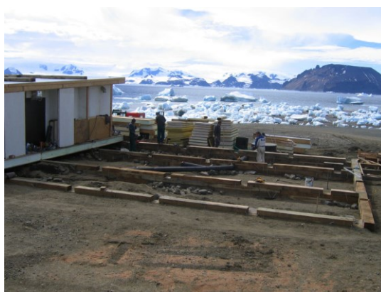
Zakládání hlavního provozního objektu
