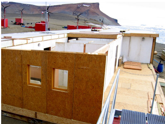
Montáž panelů systému K-KONTROL
