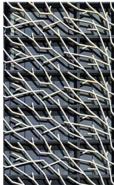
obr. 6 - pohled na uliční fasádu kancelářské budovy v Holandsku
