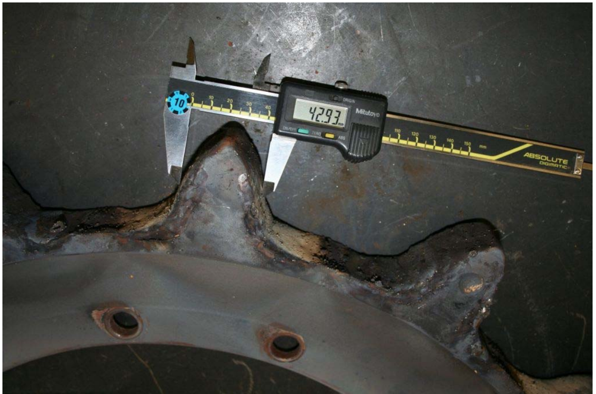
obr.14: Současný stav defektace věnce hnacího kola posuvným měřidlem
