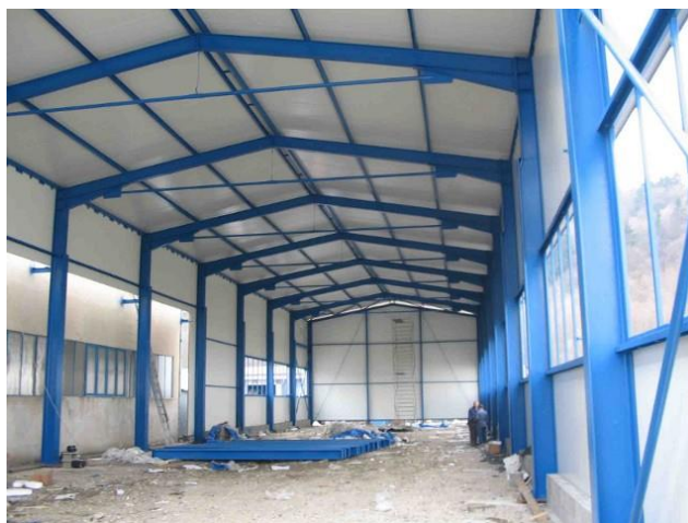
Obrázok 13: Hala oceľových konštrukcií (15)
