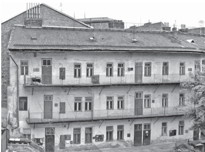
Obr. 3 Pohled na pavlačový dům
