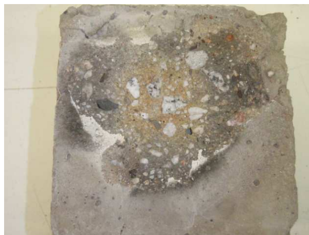
Obr. č. 8: Detail exponovaného povrchu po zkoušce, vzorek IV – vodní uložení (vlhkost 4,4 %, maximální teplota 1 279 °C)
