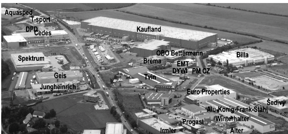
Obrázek 4: Areál obchodu a služeb Modletice (Praha východ) Zdroj: Europrojekt
