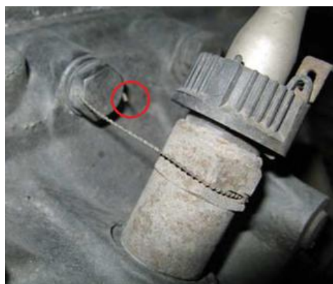
Obr. 6 Porušený plombovací drát[7]
