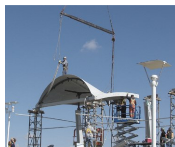
Obr. 4: Montáž skořepiny LTR Station. Zdroj: Lafarge Ductal Newsletter, č. 1, 2004
