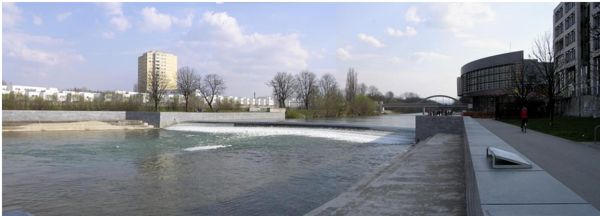
Obrázek 5 Panoramatický pohled na architektonicky řešenou část – přístup k vodě je zde řešen pomocí sedacích schodů umístěných symetricky po obou stranách břehu
