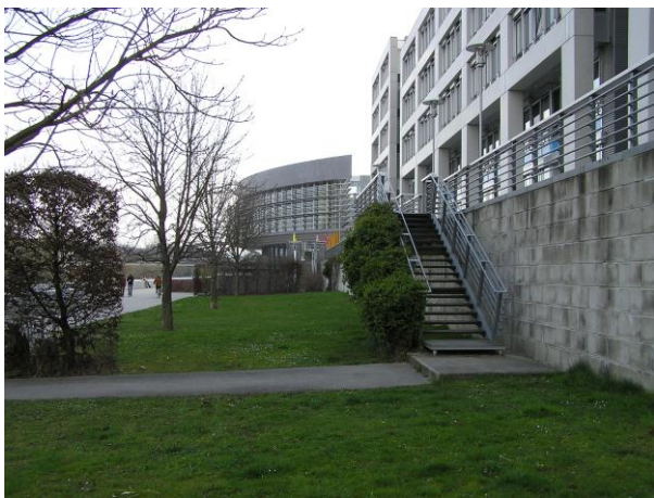
Obrázek 6 V rámci protipovodňového Opatření jsou budovy zvednuty nad terénem promenády – pokud by došlo k vylití řeky z jejího koryta byly by škody na majetku minimální
